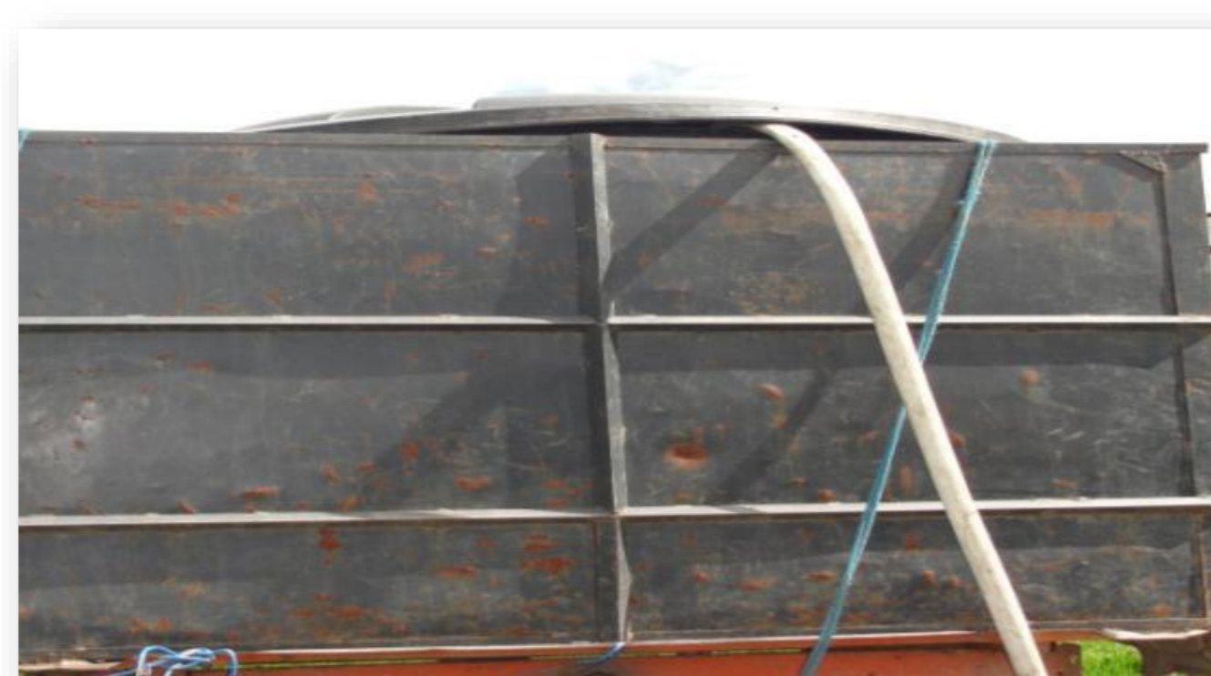
Tanque que recibe los lixiviados para ser llevados al área de ganadería
